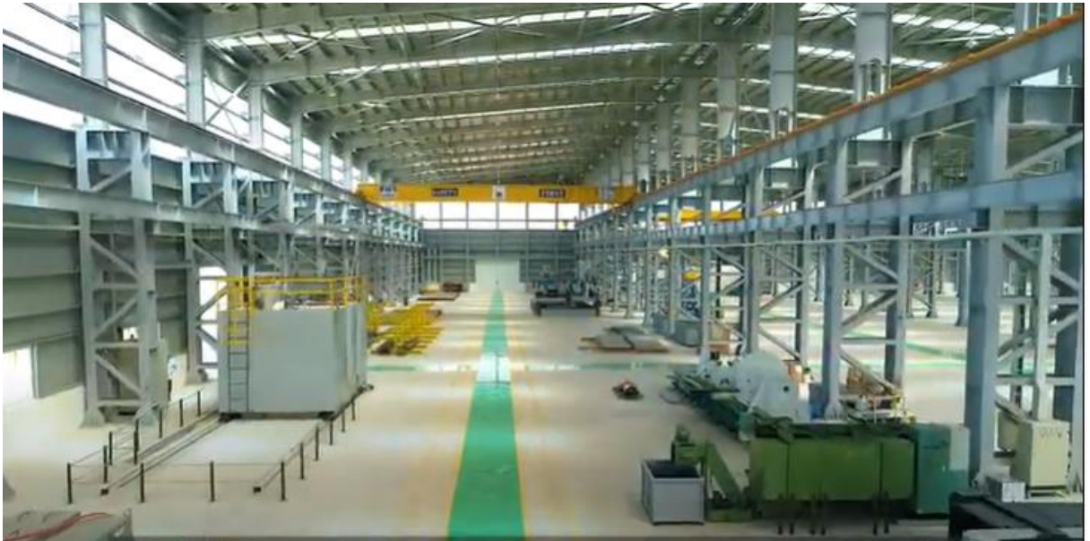
Hệ thống nhà xưởng sản xuất của Công ty TNHH UP Hà Tĩnh tại KCN Phú Vinh
