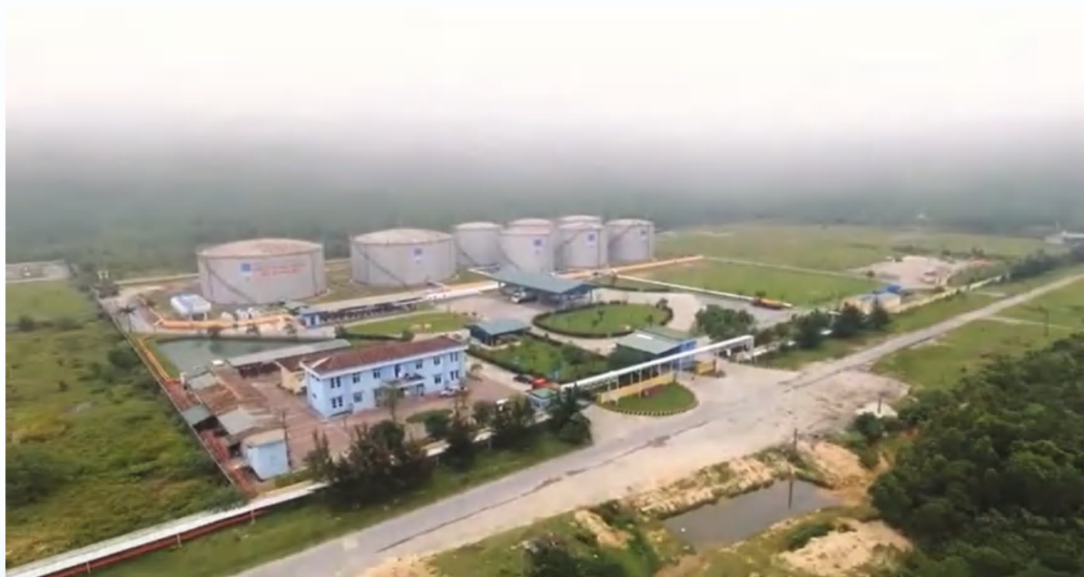
Tổng kho xăng dầu tại Khu kinh tế Vũng Áng của Công ty cổ phần xăng dầu - dầu khí Vũng Áng
